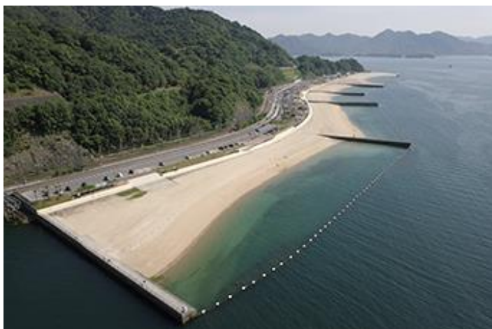
所在地：安芸郡坂町水尻 施設延長：約1,200m
