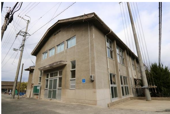
旧尾道市役所百島支所庁舎 南西外観
