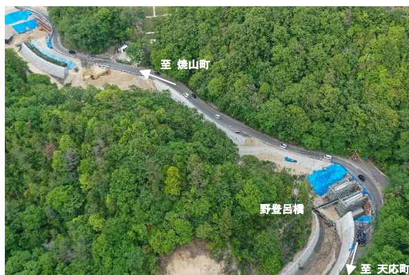
写真②橋梁下部工施工状況
