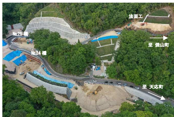
写真①法面工，橋梁下部工施工状況
