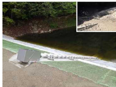
ため池の復旧工事状況 (尾道市)
