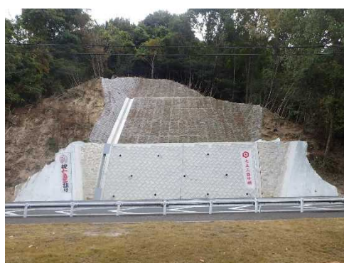
(主) 東海田広島線（安芸郡府中町）
