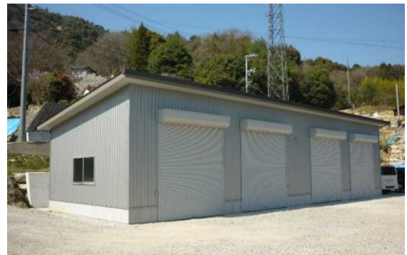
農業用倉庫の復旧状況（呉市）
