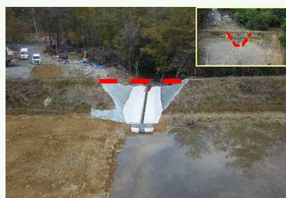
ため池の廃止工事状況（安芸高田市）
