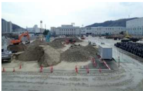
二次仮置場（坂町）処理中
