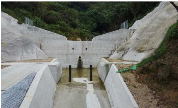
砂防指定地内河川 天地川支川10 災害関連緊急砂防事業 (坂町小屋浦)
