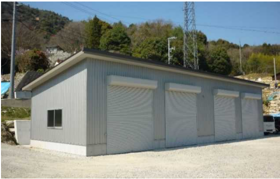
農業用倉庫の復旧状況 (呉市)
