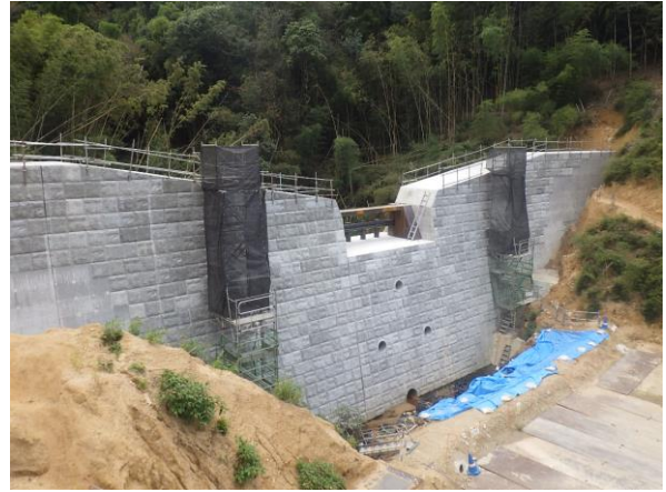
県：砂防激甚災害対策特別緊急事業 水落川 (坂町水尻)
