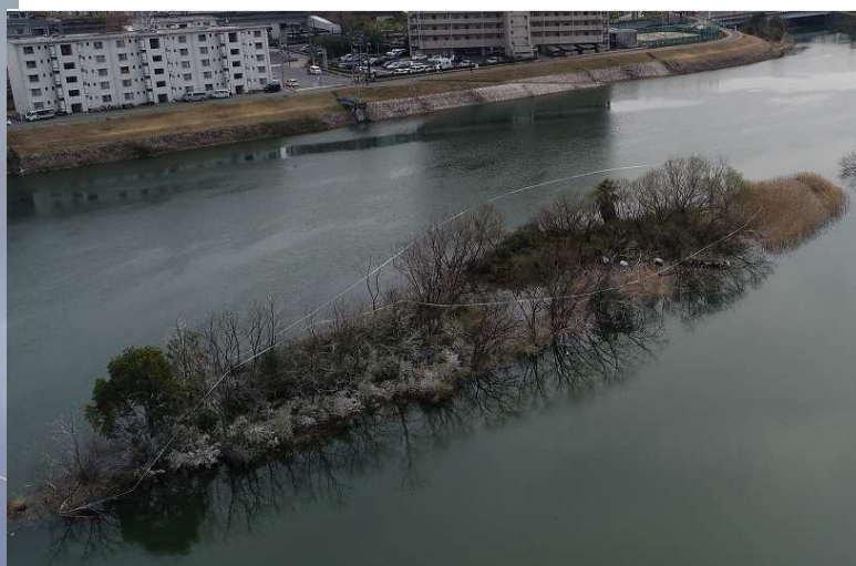
ドローンで実施したテープ張り後の状況 R3. 2. 15 白島（西部管理ユニット）
