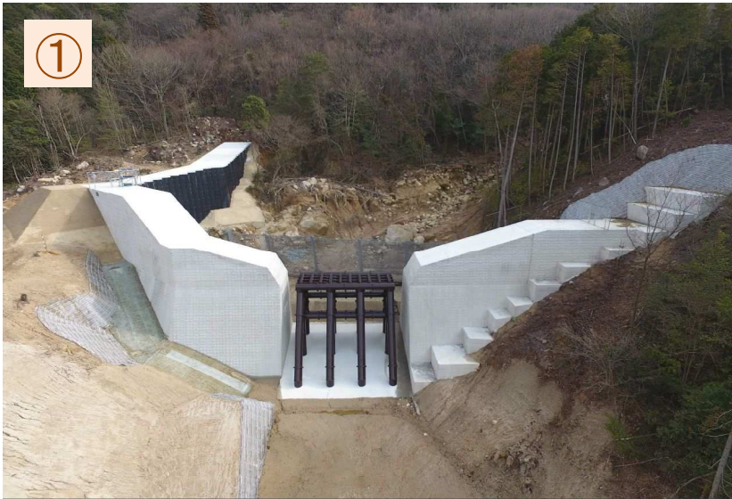
砂防堰堤①（本体工）令和元年12月3日完成
