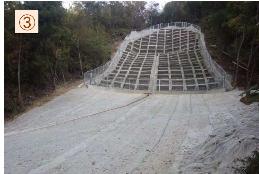
急傾斜対策（法枠工）令和元年11月22日完成
