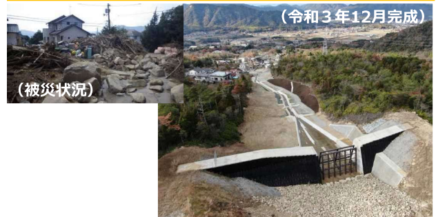
【小谷川 砂防激甚災害対策特別緊急事業 (東広島市)】
