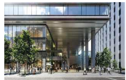
高層棟低層部
