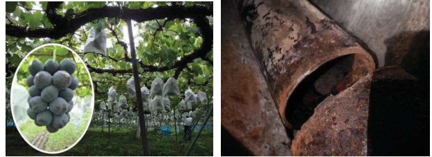
ぶどう産地における突発事故の状況(三次市)
