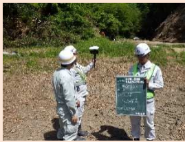
施工位置の確認(県職員)
