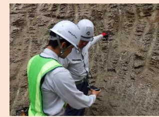
掘削位置確認
