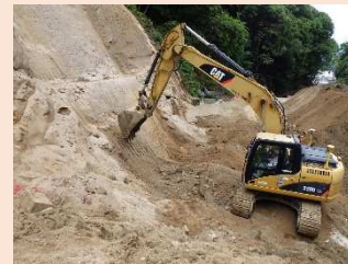
掘削作業状況
