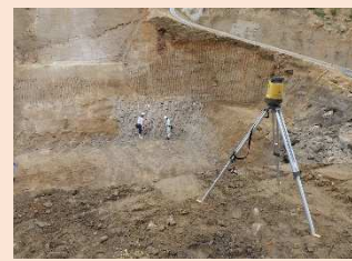
掘削位置確認
