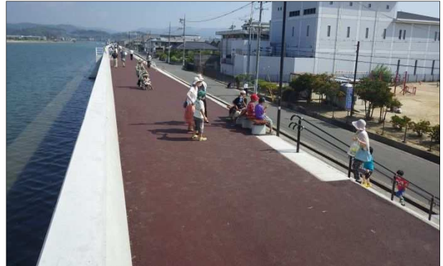
尾道糸崎港海岸堤防
