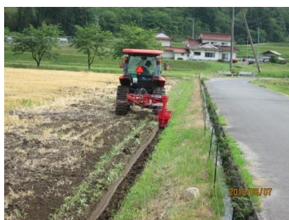
①明渠の設置
