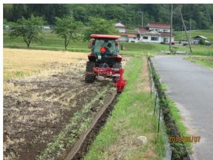
①明渠の設置
