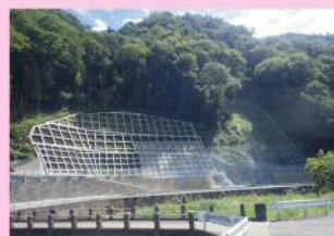
【法面对策】 (主) 府中上下線 久佐工区 (府中市阿字町) 【R2 完成】
