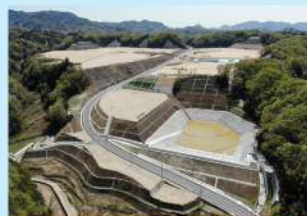
(一) 三原本郷線 本郷工区 (三原市高坂町～本郷町) 【R2 完成】
