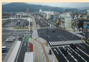
国道183号 十日市工区 (三次市十日市南) 【H29 部分完成】
