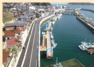
(一) 豊島線 小野浦工区 (呉市豊浜町) 【R1 完成】
