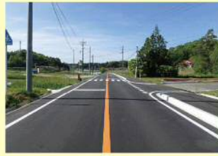
(主)世羅甲田線 青水工区 (世羅郡世羅町) 【R1 完成】
