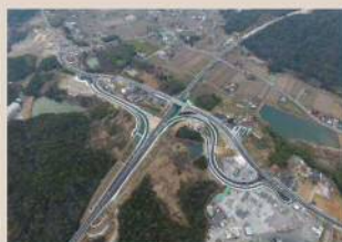
東広島呉道路 大多田IC (東広島市黒瀬町) 【H29 完成】
