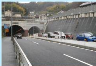
国道185号 休山新道4車線化 (呉市本通～阿賀中央) 【H30 完成】
