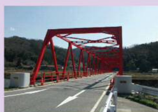
【橋梁補修】 国道433号 式敷大橋 (安芸高田市高宮町～三次市作木町) 【H29 完了】
