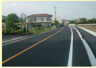
国道375号 乃美尾工区 (東広島市黒瀬町) 【R2 完成】
