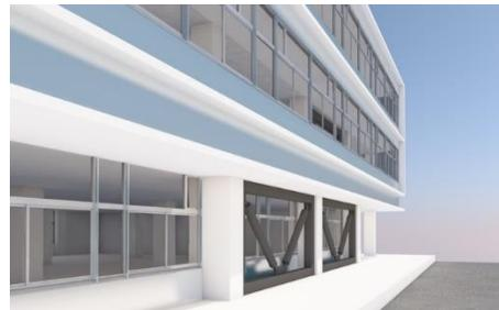
南館はピロティ部が1層分であり、工事範囲が外部だけで完結する外部側へのブレース補強とする。外観への影響を考慮し鋼管ブレースを採用し、低騒音での施工が可能な工法とする。
