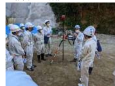
ICT施工現場研修
