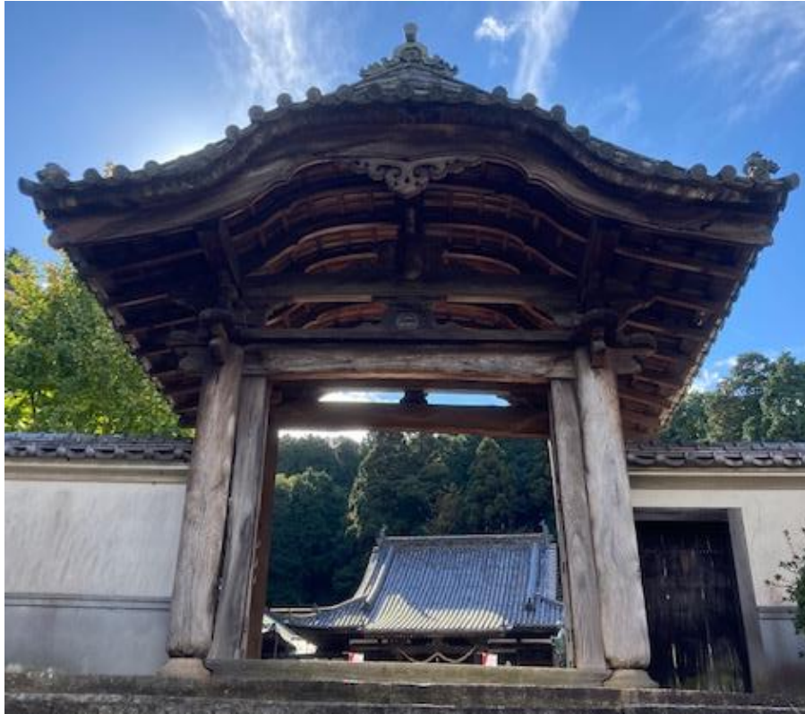
唐門正面（参道階段側より）
