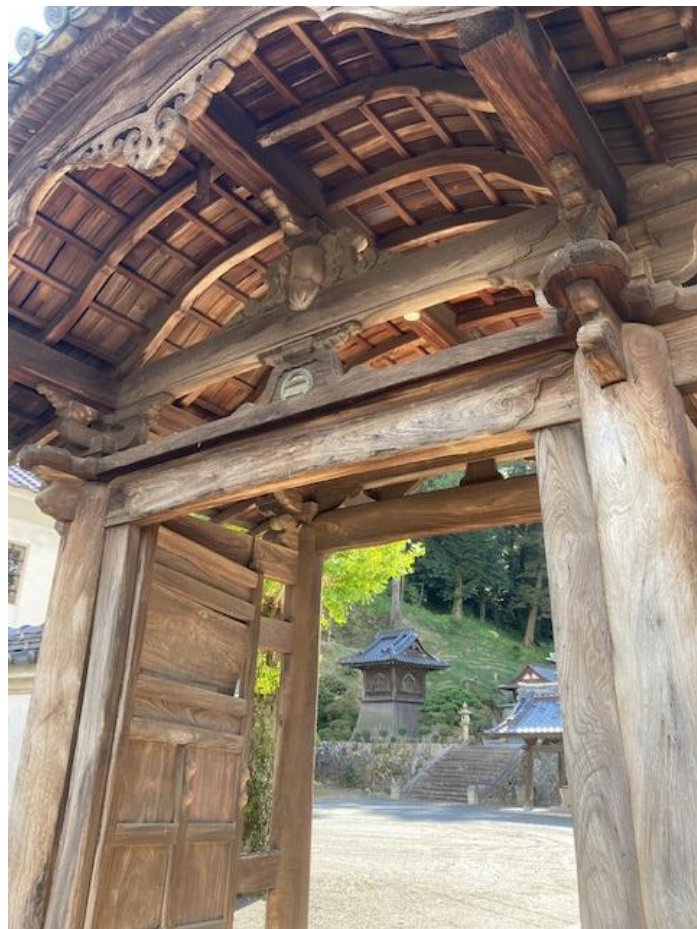
唐門正面（参道階段側より）
