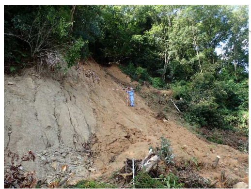
斜面崩壊・被災状況（H30年7月）
