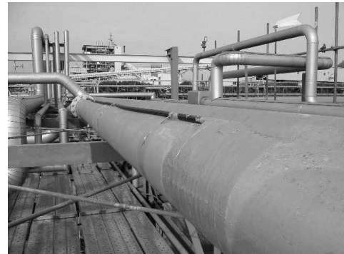
図9 検査した配管の外観写真
