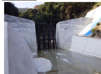
工事状況（令和3年11月19日）
