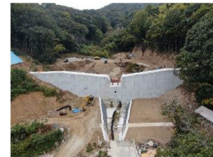
工事完了（令和3年11月15日）
