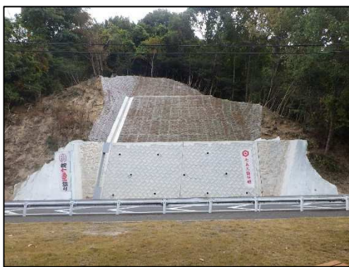
(主) 東海田広島線（安芸郡府中町）
