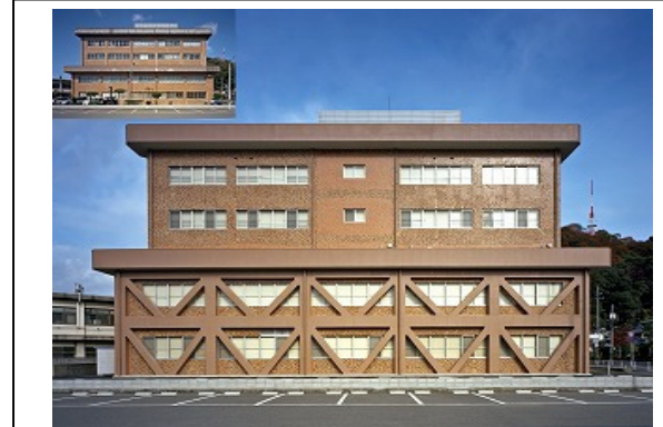
耐震改修工事
