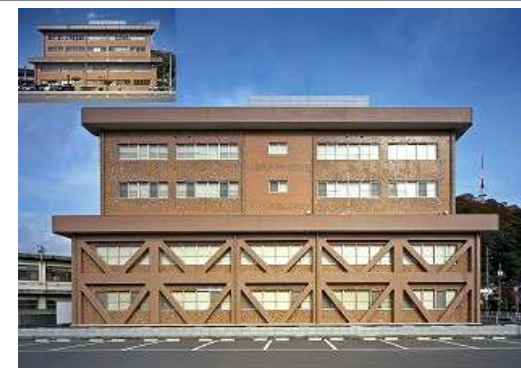
耐震改修工事
