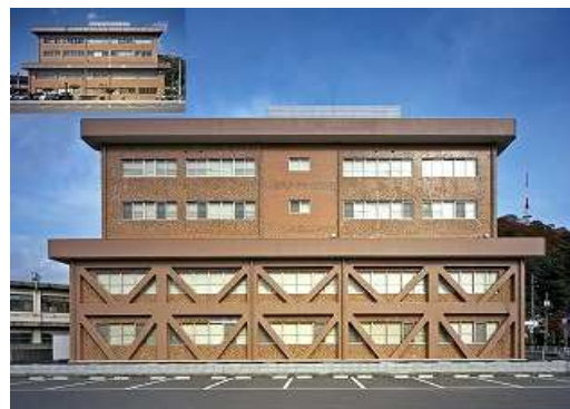
耐震改修工事
