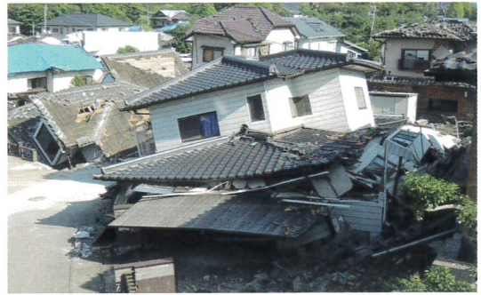
地震による被害例（熊本地震）
