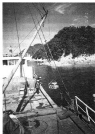
写真1 ブロックの海底設置作業
