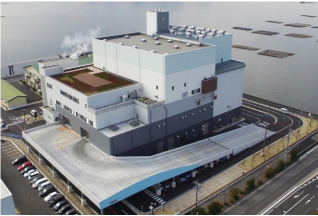
はつかいちエネルギーグリーンセンター（廿日市市）
