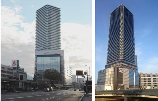
施工後 Cブロック
