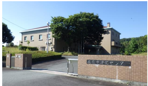
庄原市浄化センター（庄原市）
