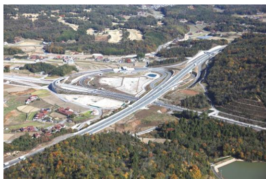
東広島呉自動車道（高屋 JCT・IC）（東広島市）
