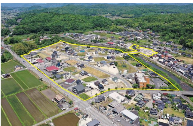
施工後（令和元年）
