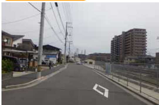
駅北 3 号線（廿日市市）
