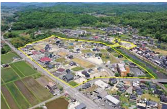
施工後（令和元年）
