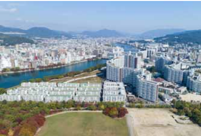
市営基町住宅（広島市）©広島市
