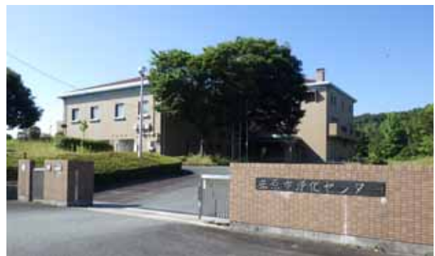
庄原市浄化センター（庄原市）
