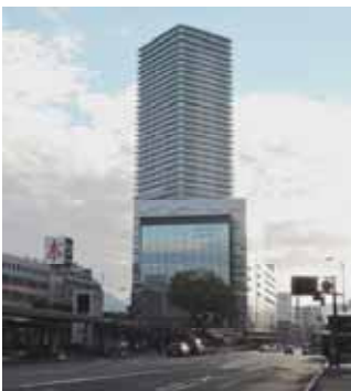
施工後 Cブロック
