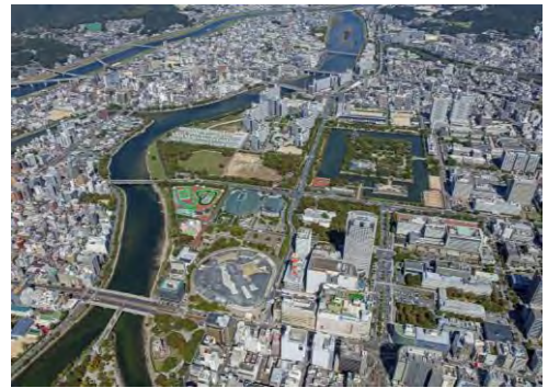
基町特定街区（広島市） ©広島市
