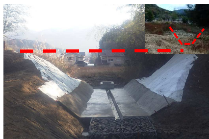
ため池の廃止工事状況（竹原市）
