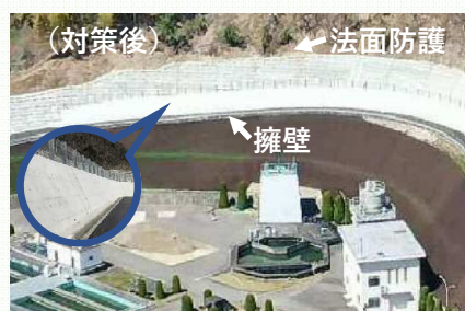
瀬野川浄水場（法面防護）
