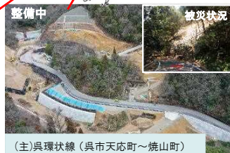
(主)呉環状線(呉市天応町～焼山町)
