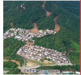
【平成30年7月豪雨の被災例】
