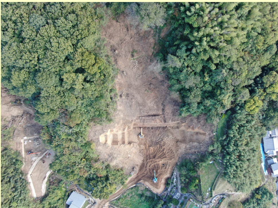
掘削工(R2.10月末時点)
