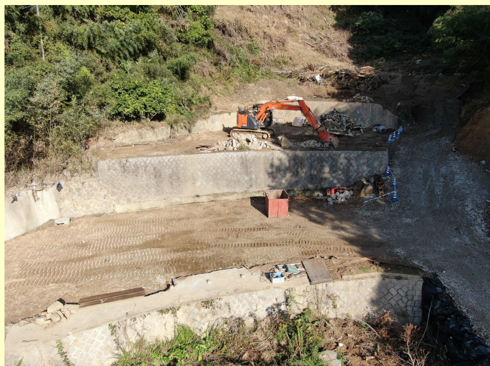
工事用道路工 (R2.10月末時点)
