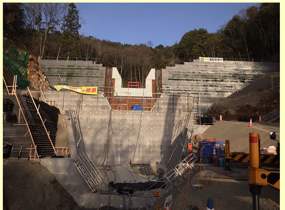
側壁護岸工(R3.3月末時点)
