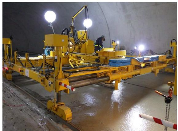
トンネル内コンクリート舗装の施工状況 [令和3年2月]
