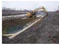
河道掘削 (石狩川水系、北海道開発局)
