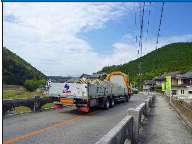
【整備前の状況(起点側)】
