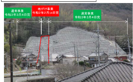
工事完了（令和3年3月4日）
