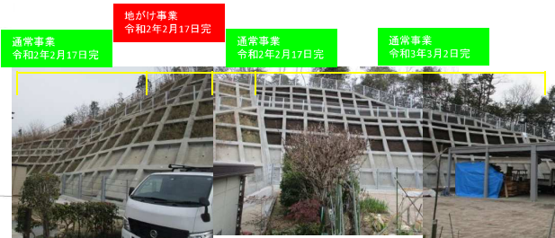
工事完了（令和3年3月2日）
