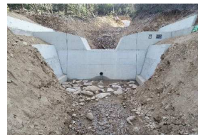
【完成状況(25溪流 2号 谷止工)】
