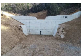
【(完成状況(24溪流 2号谷止工))】
