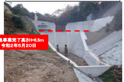
工事完了（令和2年12月21日）
