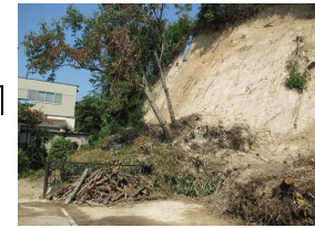
斜面崩壊・被災状況（H30年7月）
