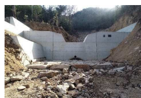
【完成状況(25溪流 2号 谷止工)】
