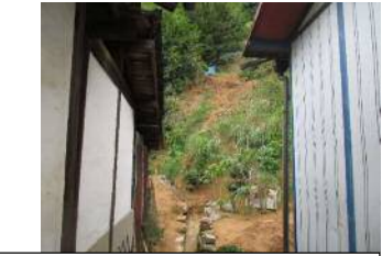
斜面崩壊・被災状況（H30年7月）
