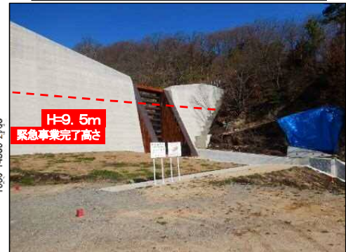
工事完了（令和3年2月25日）
