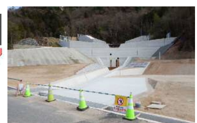
工事完了（令和3年3月10日）
