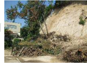
斜面崩壊・被災状況（H30年7月）
