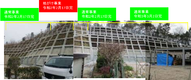
工事完了（令和3年3月2日）
