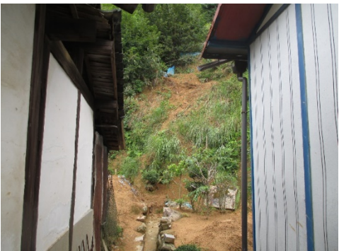
斜面崩壊・被災状況（H30年7月）
