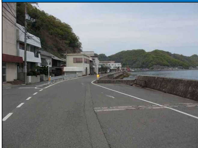
【整備前の状況(終点側)】
