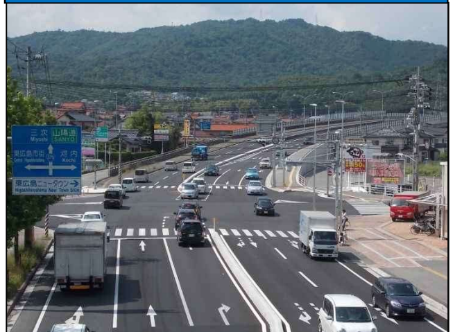
【4車線供用区間(区間③)】
