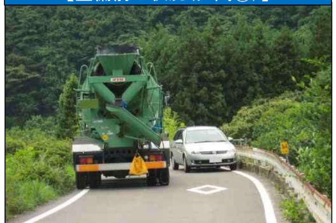
【整備前の状況(区間②)】
