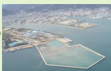
災害発生土や 浚渫土等の受入施設 (尾道系崎港貝野地区)
