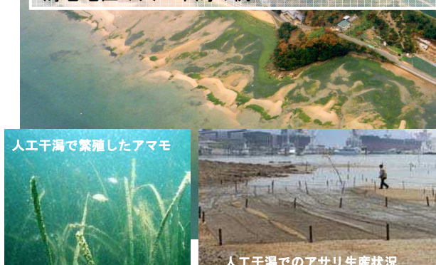
機織地区航路泊地の浚渫土を有効利用した海老地区の人工干潟の例
