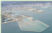
災害発生土や 浚渫土等の受入施設 (尾道糸崎港貝野地区)
