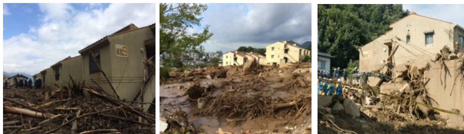
【写真】 県営緑丘住宅被災状況
