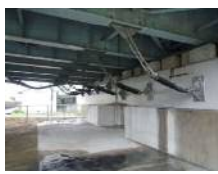
橋梁耐震工事例 (落橋防止)
