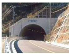
道路改良工事例 (バイパス整備)
