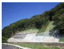
法面災害防除工事例 (法枠工等)
