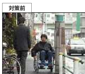
移動円滑化を妨げる電柱
