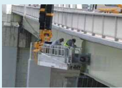
橋梁の点検状況
