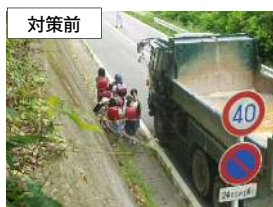
歩道がなく 大型車通行時に危険
