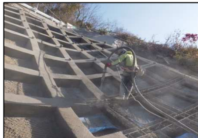
県急傾斜事業 刈浜地区 (呉市蒲刈町)
