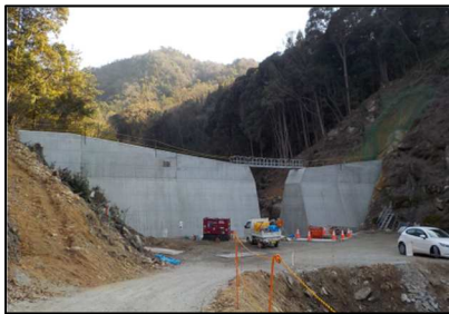
県砂防事業 天地川支川2 (坂町小屋浦)
