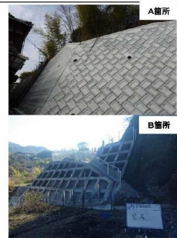
工事完了（令和3年1月29日）
