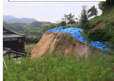
斜面崩壊・被災状況（H30年7月）
