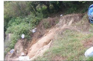
斜面崩壊・被災状況（H30年7月）
