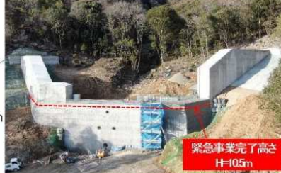
工事完了（令和3年1月29日）
